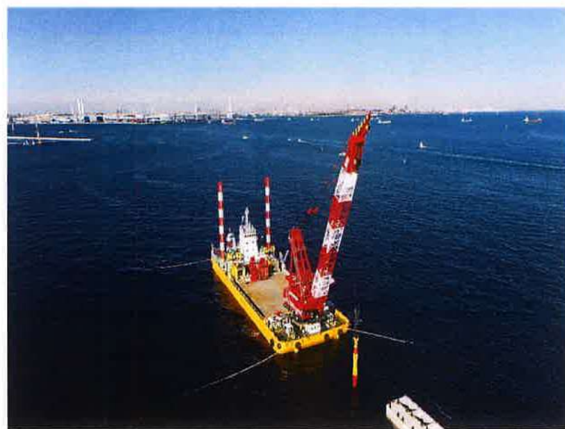
施工状況 全景
