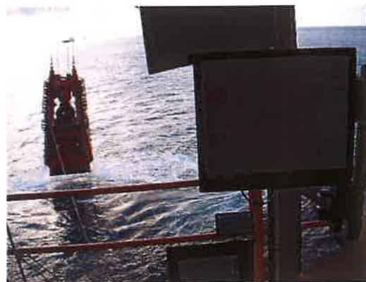
起重機船クレーン操縦室より撮影
