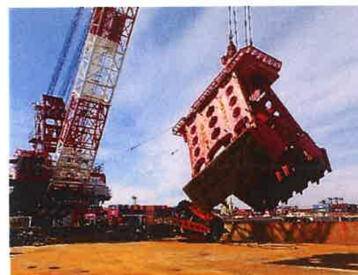
法面バケット開放状態
