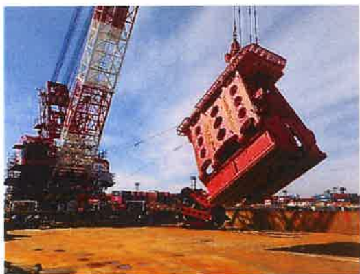
法面バケット閉塞状態
