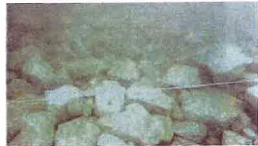
写真. 3 捨石均し施工完了
