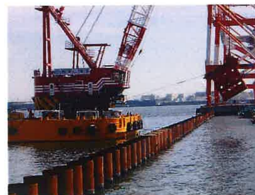
施工状況②
