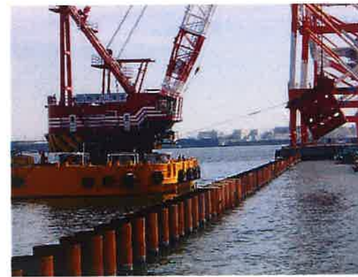
施工状況②
