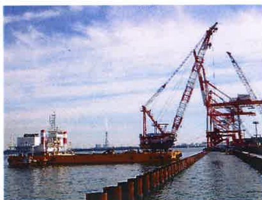
施工状況①
