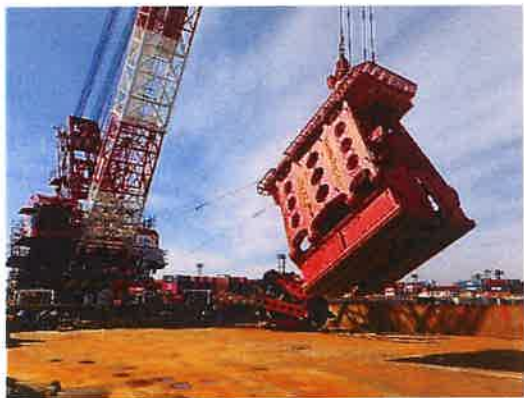
法面バケット閉塞状態
